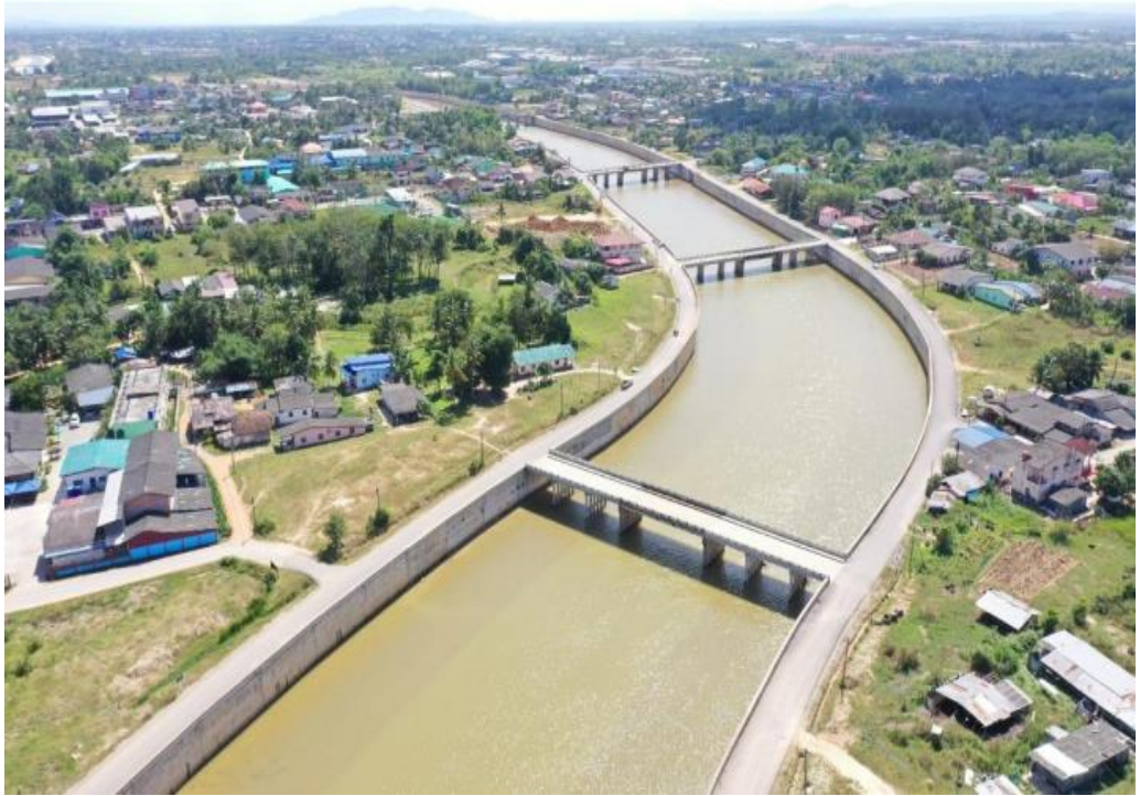
รูปที่ ๗ ปรับปรุงสะพานรถยนต์
