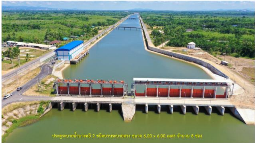
รูปที่ ๔ ก่อสร้างประตูระบายน้ำบางหยี ๒ ชนิดบานระบายตรง จำนวน ๘ ช่อง
